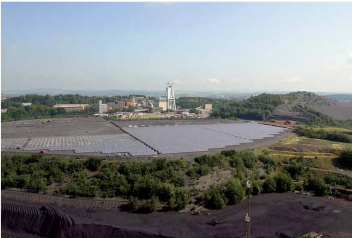
Atemberaubend: Der Blick vom Kraftwerk Weier auf den Zukunftsort mit dem im Bau befindlichen Solarkraftwerk (2004).
