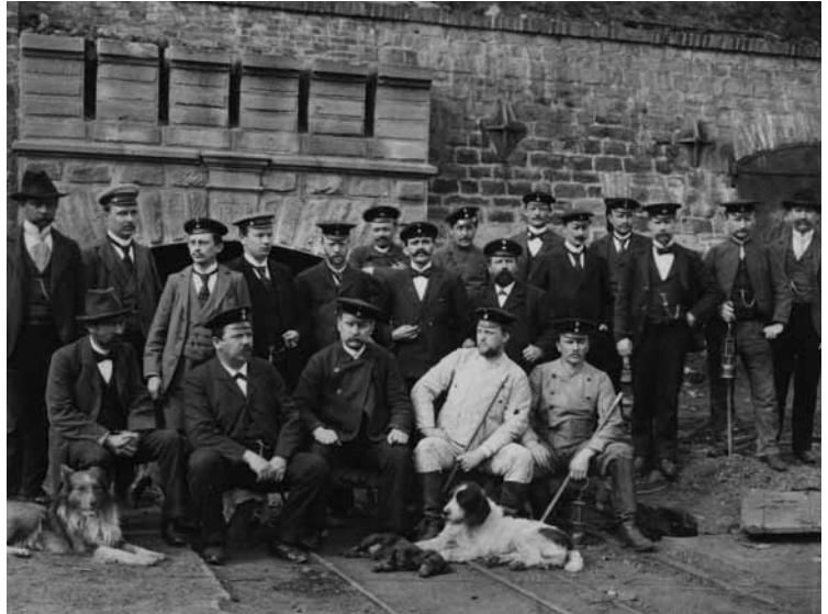
Aus den Anfängen der Grube Göttelborn: Preußische Bergbeamte vor der Mundlocharchitektur Tagesstrecke Flöz Eilert (19.02.1903).
