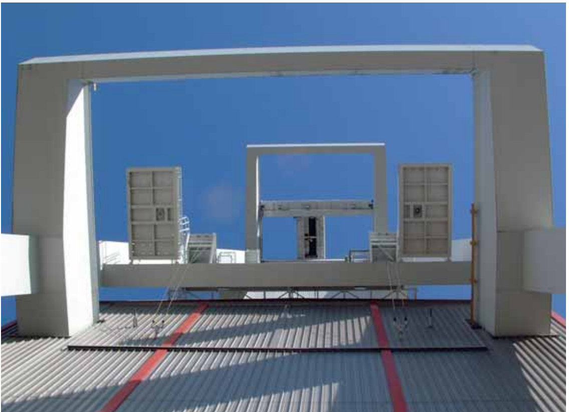
Göttelborn IV – 90 Meter „Technik pur“.
