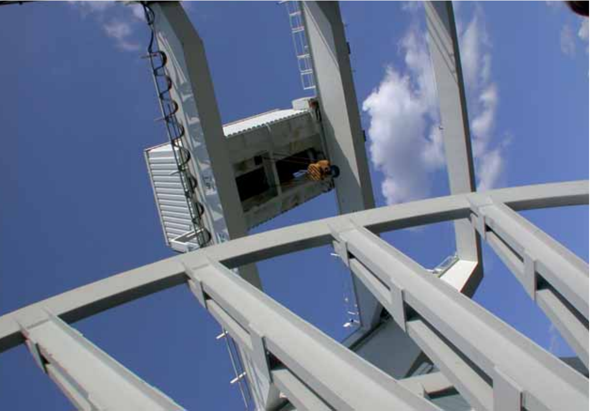
Göttelborn IV: Schwindel erregend der Blick hinauf zum Kranaufbau (2003).
