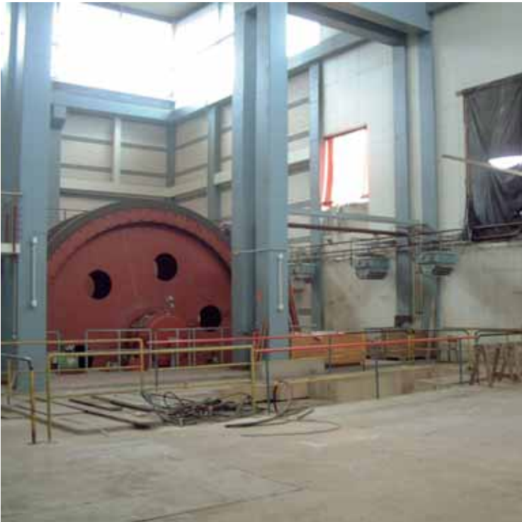
Das Innere des Fördermaschinenhauses Schacht IV – nur die östliche Förderung wurde montiert (2002).
